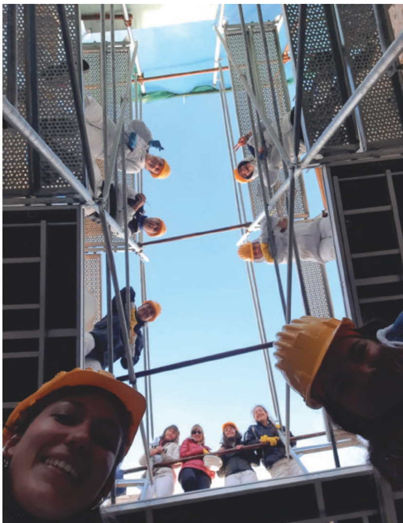
Gli allievi della scuola Engim Veneto professioni del Restauro, sul ponteggio della torre durante il cantiere scuola
